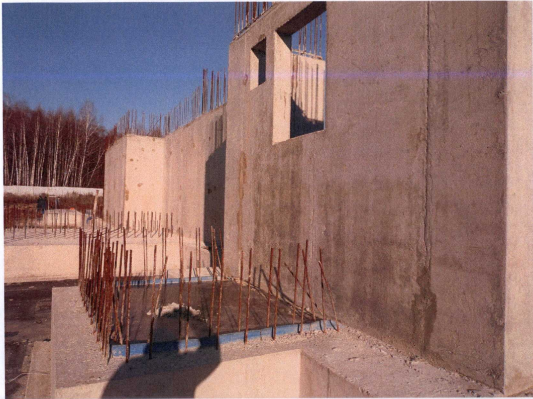
Фото № 5. Вид смонтированных стен подвала секции 7
