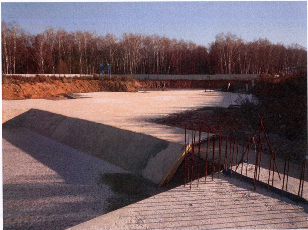
Фото № 13. Вид на секции 4,3 со стороны секции 5
