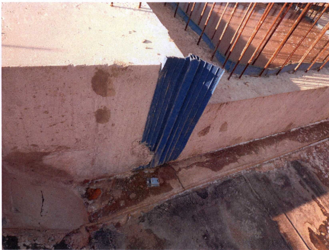
Фото № 8. Гидроизоляционная шпонка в зоне деформационного шва
