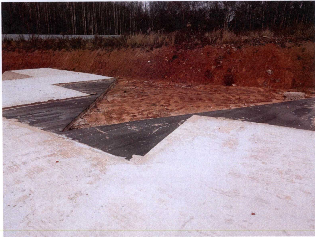
Фото № 14. Цементная подготовка в зоне секции 3
