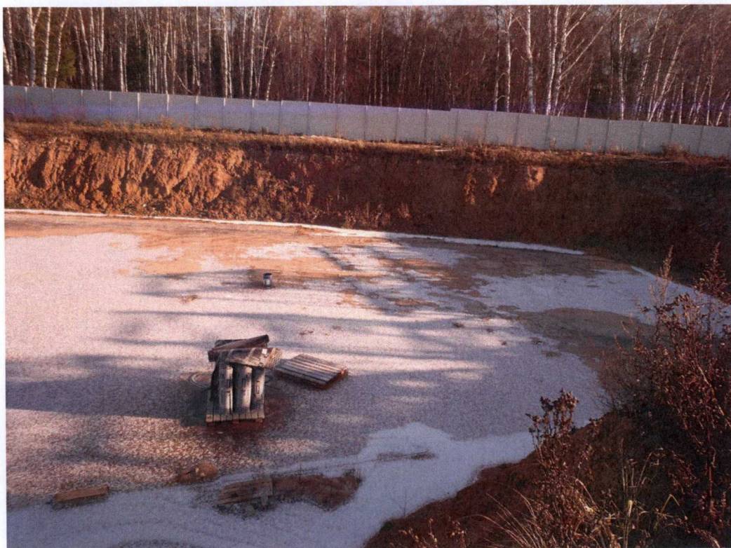
Фото № 21. Вид секции 1
